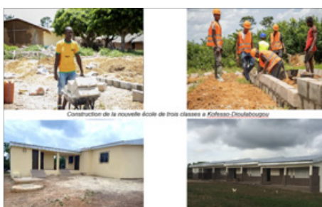
Construction de l'école à Kofesso dans le cadre de notre partenariat communautaire
